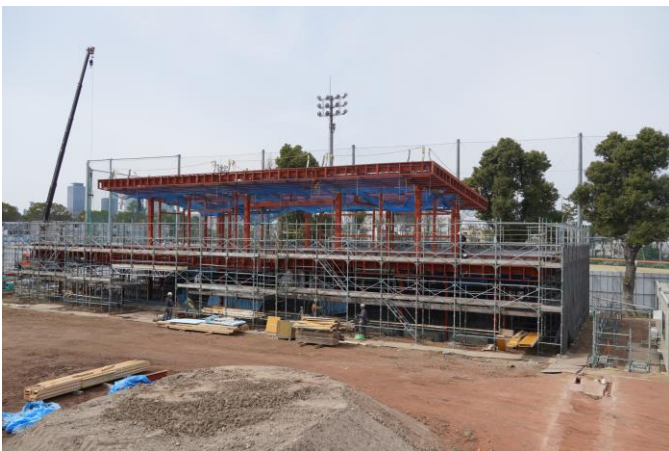
⑧a 2024.3.19 (火) 本体鉄骨建て方、外部足場架構
