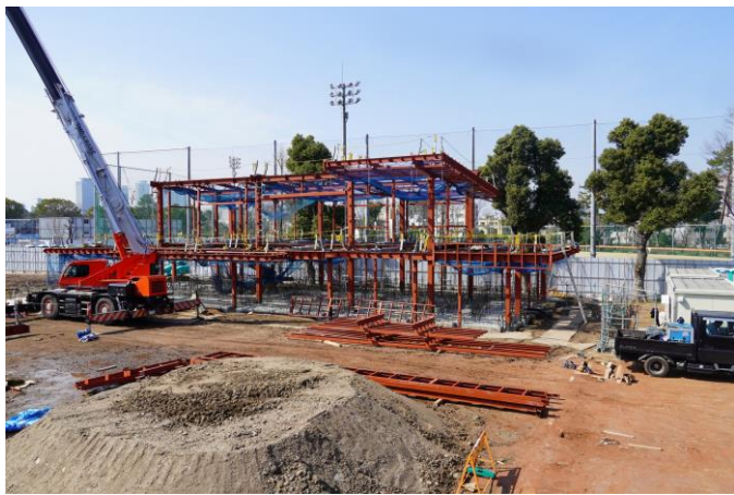
⑧a 2024.3.19 (火) 本体鉄骨建て方、外部足場架構
