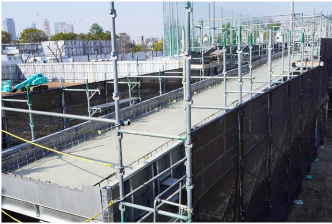
⑪2024.3.30 (土) 連絡通路 床：コンクリート打設
