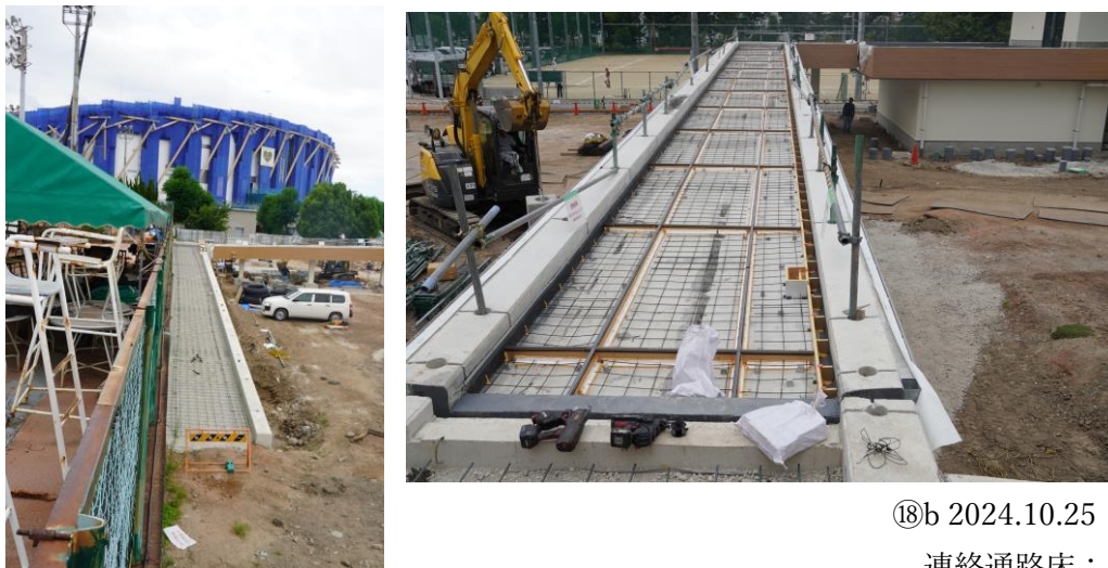
⑪2024.9.21（土）連絡通路&スロープ：床配筋
