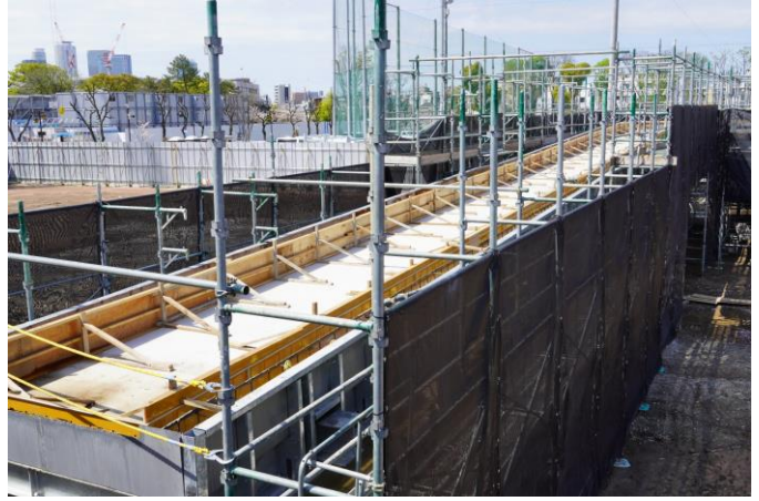
⑫2024.4.10 (水) 連絡通路 立上り：型枠設置
