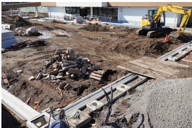
⑩a2024.10.25（金）排水溝、ネットフェンス基礎 設置
