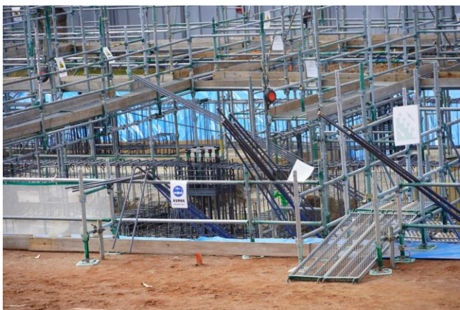
⑤a 基礎コンクリート打設完了、埋戻し開始
