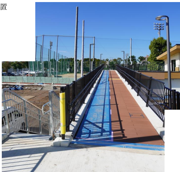
⑩b 2024.10.25（金）鉄骨階段設置 連絡通路床：人工木デッキ敷き込み アルミ手摺設置、照明用ポール設置
